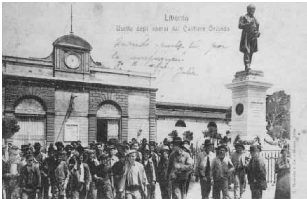
Uscita degli operai dal Cantiere Orlando. Biblioteca Labronica "F.D. Guerrazzi", Livorno
