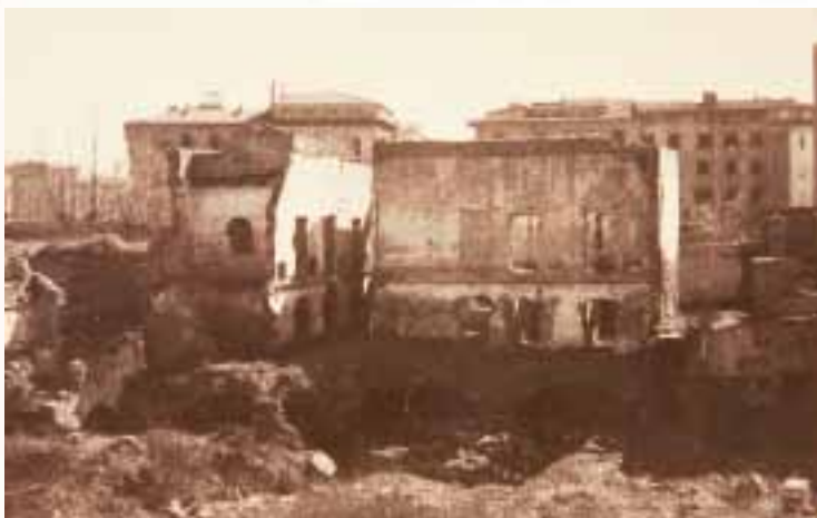
L'interno della Fortezza danneggiato dai bombardamenti, CLAS, Fortezza Nuova
