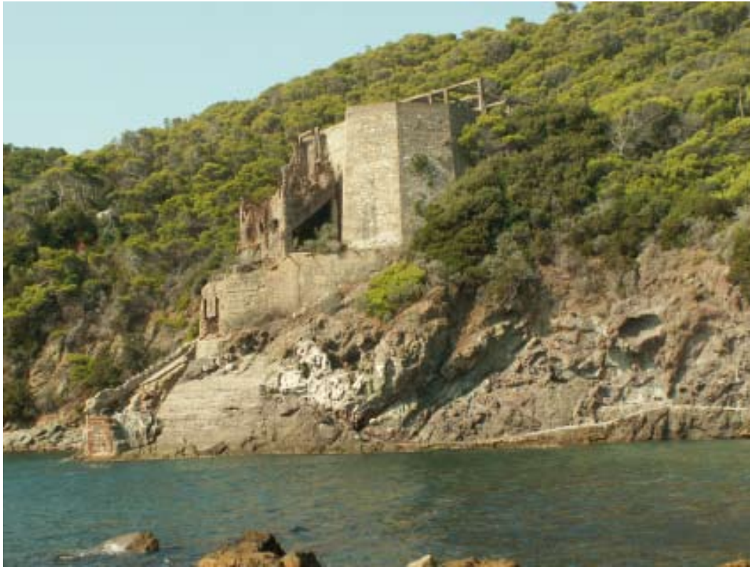
Baia di Quercianella: ruleri del caricatoio della pietra calcarea estratta dalle cave di Pietralta
