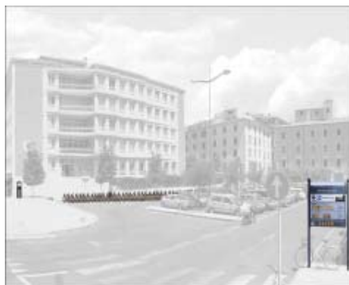
Piazza Giovine Italia prima dell'intervento Piazza Giovine Italia: fotoinserimento degli interventi previsti
