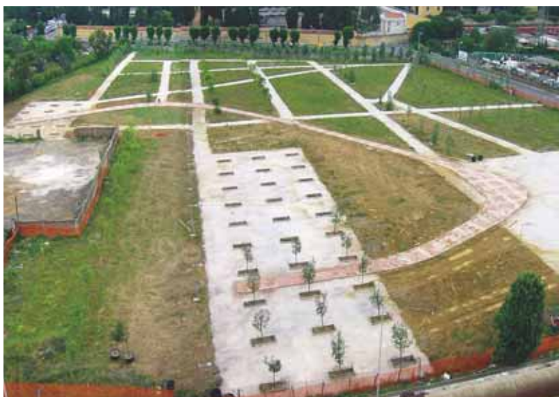
Sopra: L'area prima e durante i lavori
