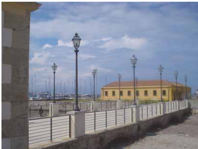
Sopra: Violetto di ingresso dello Scoglio della Regina recentemente restaurato
