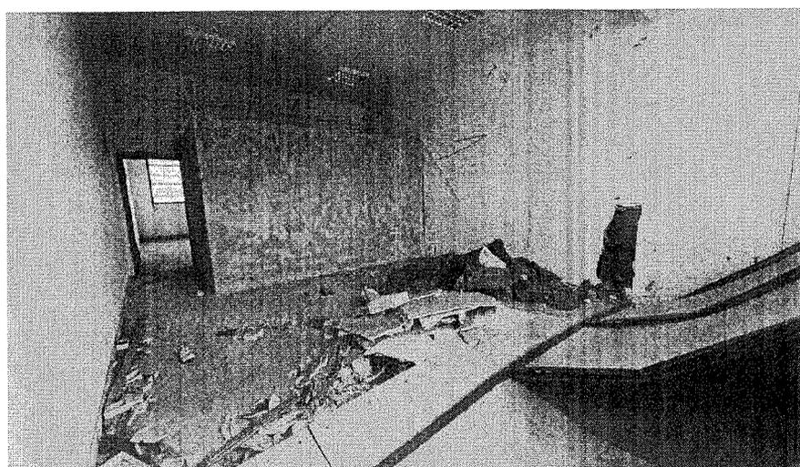
**Foto 39, 40 e 41 – Altre immagini della stanza n. 2 con evidenziati i materiali da rimuovere e smaltire, le pareti da demolire e gli infissi da mettere in sicurezza**
